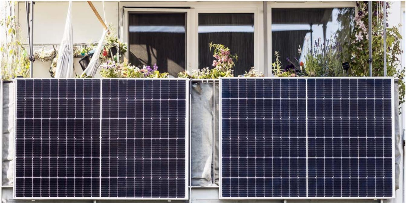
Die Energiekrise bringt viele Menschen dazu, einen Teil des Strombedarfs im Haushalt selbst erzeugen zu wollen. Kleine Photovoltaikanlagen, die am Balkon angebracht und an die Steckdose angeschlossen werden, machen dies für Eigentümer und Mieter möglich.
