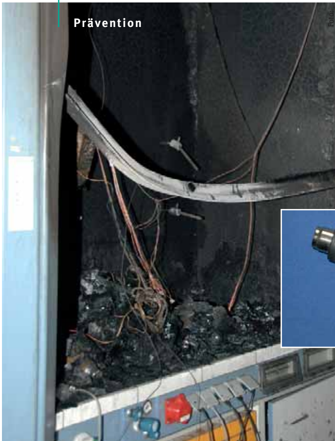
Zerstörtes Labor: An einer Heatgun hatte sich Diethylether entzündet
