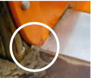
Fotoğraflar, kordonların oyun araçlarının nerelerine takılabileceklerini gösteriyor.
